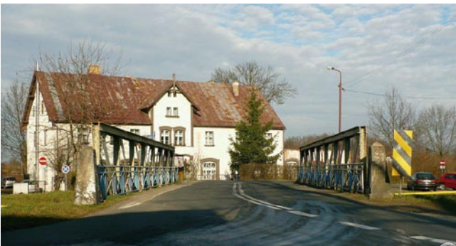
Rys. 8. Widok obiektu od strony od strony Mysłakowic – widoczne odbojnice wraz z dźwigarami kratownicowymi i balustradami (źródło: www.polska-org.pl)
