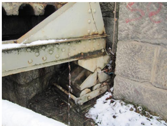
Rys. 6. Widok istniejącego łożyska (zdjęcie własne autora)
