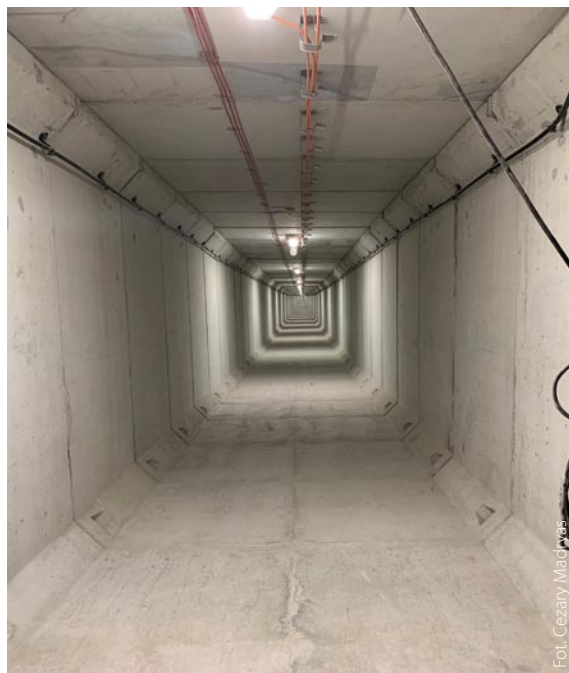
Korytarz ewakuacyjny w tunelu w Świnoujściu
