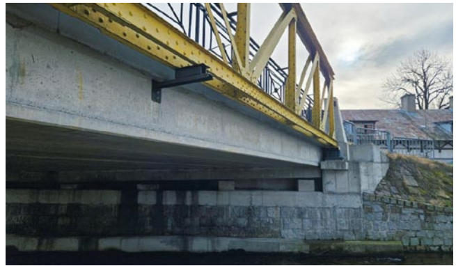
Rys. 15. Widok przęsłowego podparcia w kierunku prostopadłym do płaszczyzny dźwigara kratowego – stan obecny (zdjęcie własne autora)
