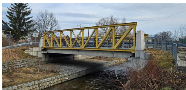
Rys. 13. Widok mostu od strony wody górnej – stan obecny (zdjęcie własne autora)
