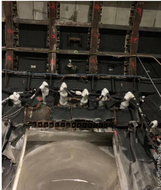
Budowa wyjścia estymacyjnego z tunelu w Świnoujściu
