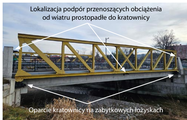
Rys. 12. Widok lokalizacji podparć dźwigara kratowego – stan obecny (zdjęcie własne autora)
