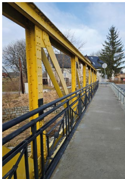
Rys. 16. Widok dźwigara kratowego i balustrady po remoncie – stan obecny (zdjęcie własne autora)
