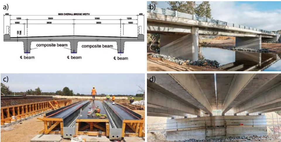
Rys. 8. Obiekty mostowe wybudowane w Australii z wykorzystaniem zespolenia ciągłego:
