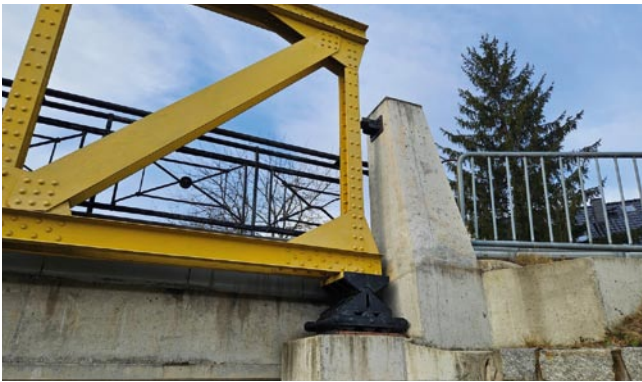
Rys. 14. Widok oparcia dźwigara kratowego na przyczółku – stan obecny (zdjęcie własne autora)
