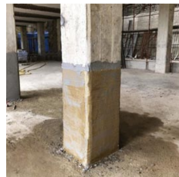
Rys. 3. Zastosowanie kompozytu PBO-FRCM – wzmacnianie ze względu na ściskanie ze zginaniem [4]
