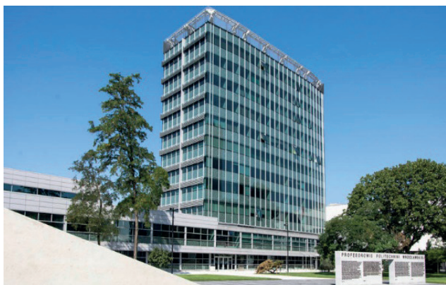
Fot. 9. Siedziba Wydziału po modernizacji
